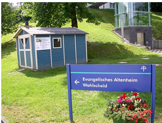
Abb. 4: Die Messstation am EAHW
